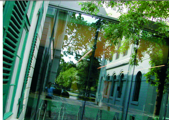
Komplexe Erfahrung des Ensembles: In dem als gläserner Kubus konzipierten Seminaranbau verschwimmen Außen- und Innenraum zu einer Gesamtheit
